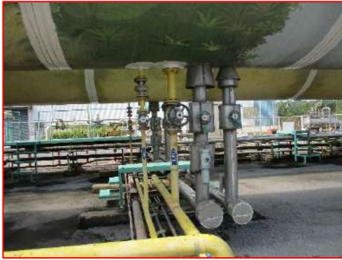
ภาพที่ 2-64 ระบบอัตโนมัติ (Interlock) ของถังก๊าซแอลพีจี
