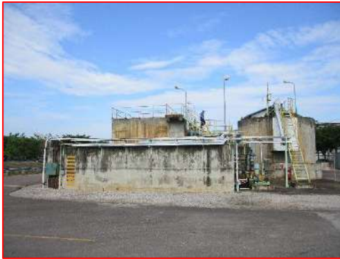
ภาพที่ 2-25 ระบบบำบัดน้ำเสีย แบบชีวภาพ
