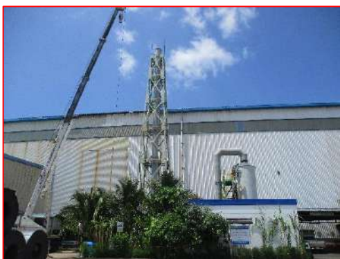
ภาพที่ 2-1 Pickling Fume Exhaust Scrubber System
