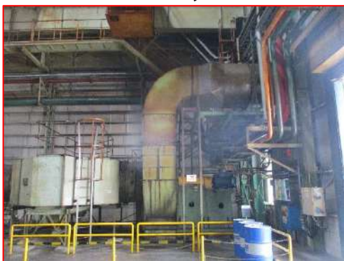
ภาพที่ 2-3 ระบบดักจับน้ำมันของปล่อง TM
