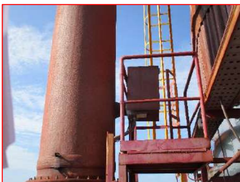
ภาพที่ 2-7 HCl Detector ติดตั้งไว้บริเวณปล่อง ARP
