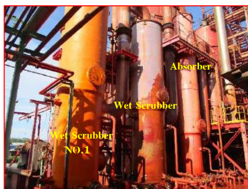
ภาพที่ 2-6 ระบบ Wet Scrubber และ Absorber ที่ปล่อง ARP
