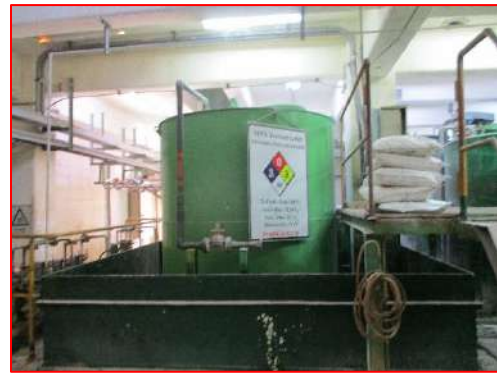
ภาพที่ 2-73 Bund Wall บริเวณพื้นที่กักเก็บสารเคมี
