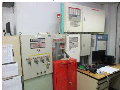
ภาพที่ 2-71 เครื่องตรวจวัดก๊าซไฮโดรเจน (Gas Detector) บริเวณพื้นที่กระบวนการอบอ่อน
