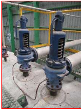
ภาพที่ 2-59 ติดตั้งลื่นนิรภัยกับหน่วยผลิตไอน้ำ
